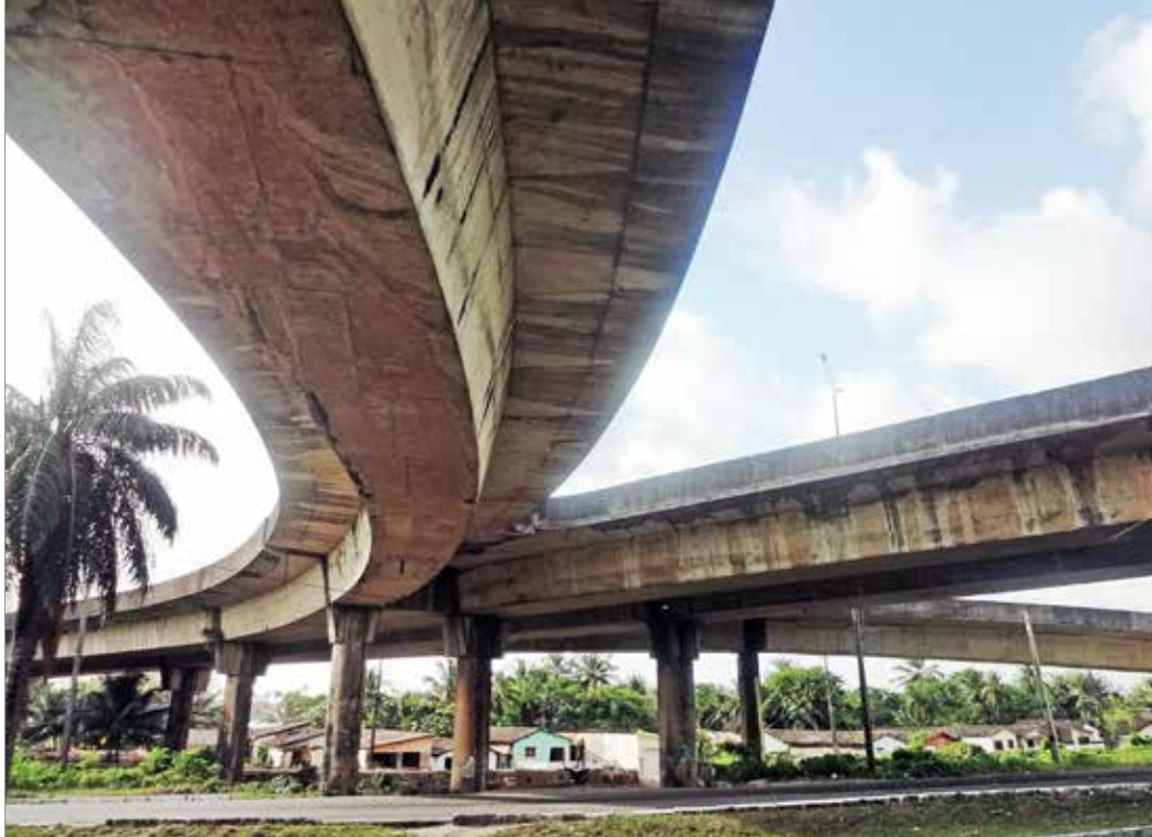
Viaduto em João Pessoa, que passou por avaliação do Sinaenco em 2012
