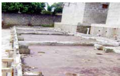
Figura 3 – Fôrma para concretagem de lajes (Canteiro, 2011)
