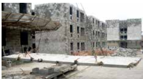
Figura 4 – Transporte de lajes (Canteiro, 2011)
