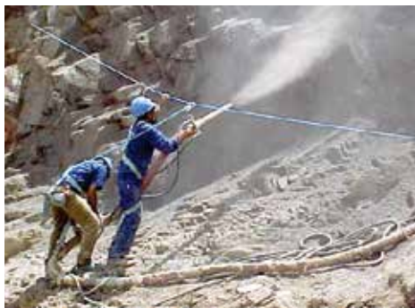
Figura 1 – Projeção de concreto para proteção de encosta rochosa recém-escavada
