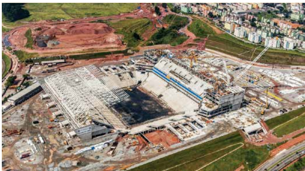
Figura 4 – Foto aérea mostrando o estado da obra
