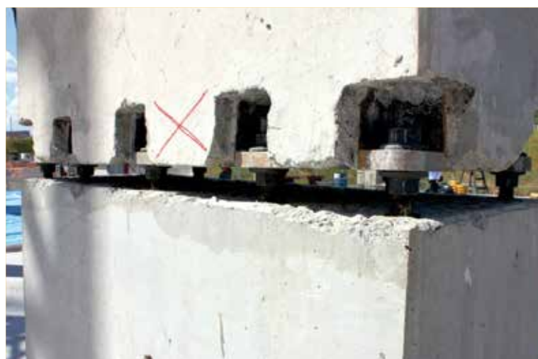
Figura 7 – Emenda de pilar pré-moldado
