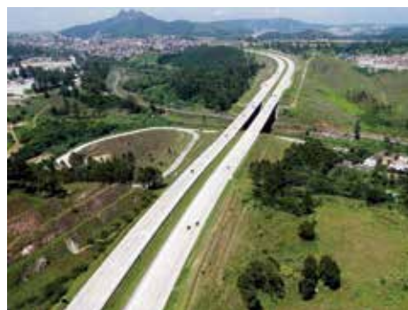
Figura 1 – Rodoanel Mário Covas (trecho Oeste)
