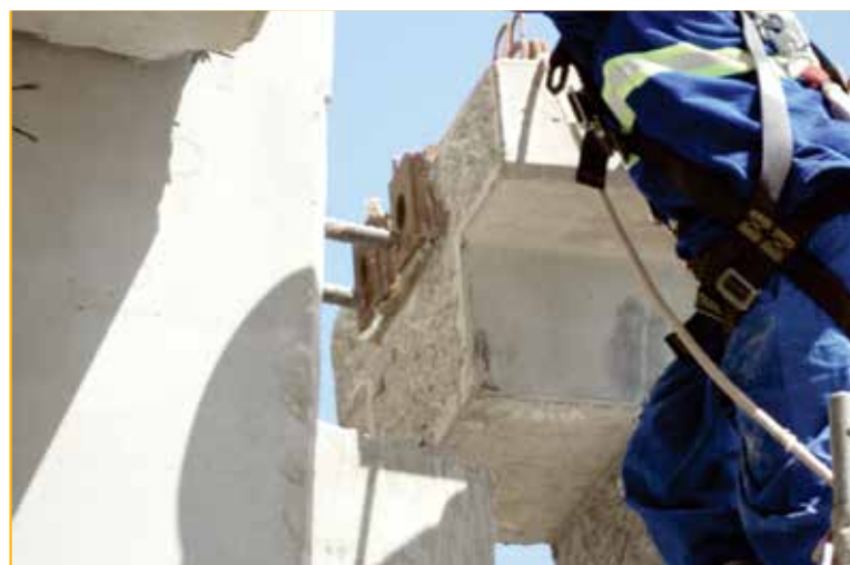
Figura 9 – Detalhe da montagem dos balanços
