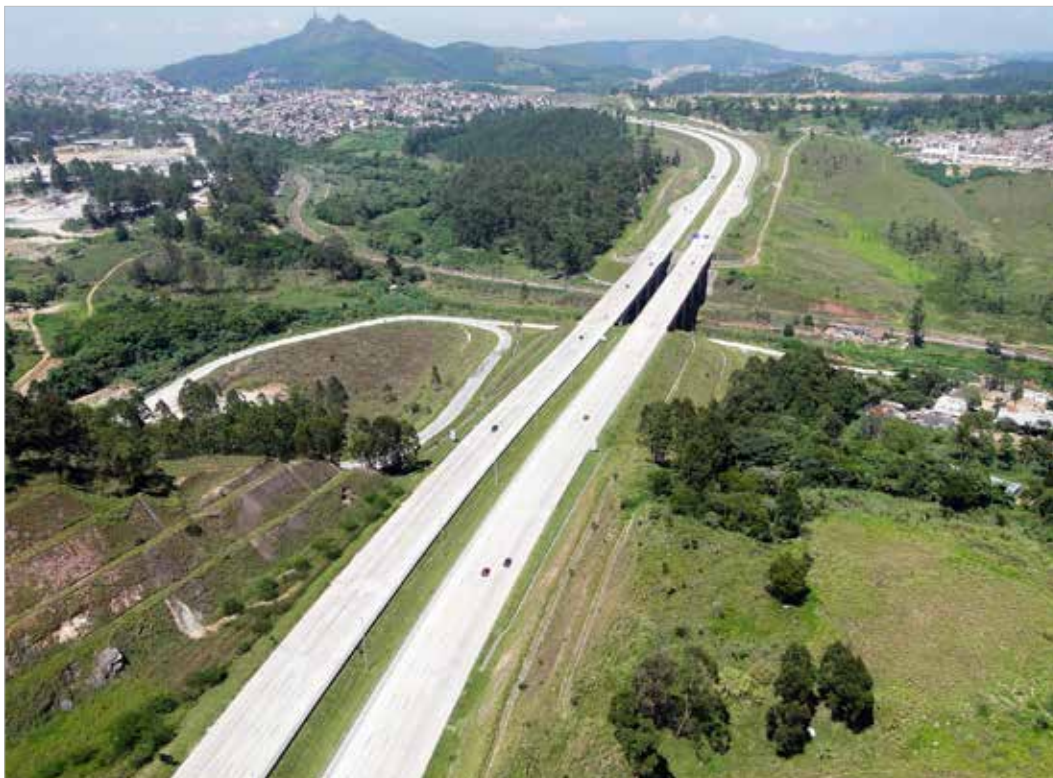
Rodoanel Mario Covas: pavimento de concreto – Dersa
